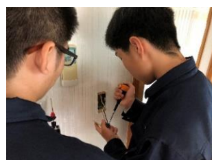
修理修繕②
