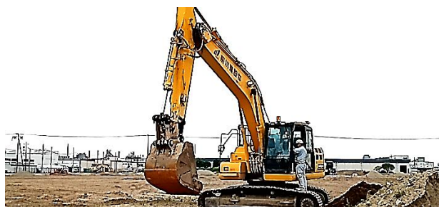
図 13、14: ICT 施工現場見学 協力: 前川建設
