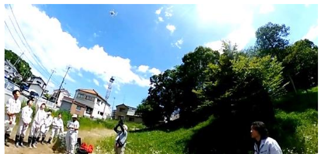
図3: UAV 測量 協力: 播磨設計コンサルタント
