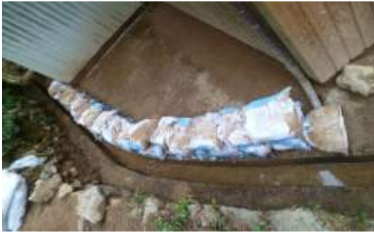
作業の終盤では30分で100のペースでつくれるようになった
