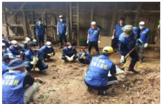
民家の山沿いに土嚢を3段積む作業の説明
