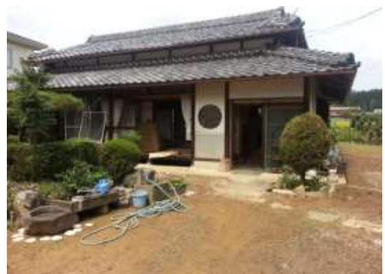
床上浸水した民家
