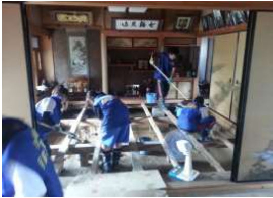
床の間の床下の泥除去
