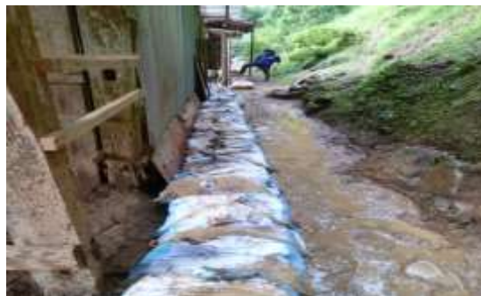
土嚢は全部で200作った。
