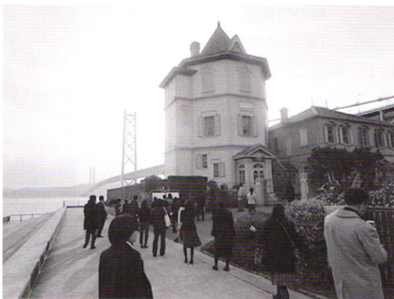
移情閣と明石海峡大橋
