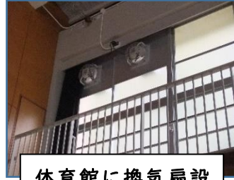
体育館に換気扇設
