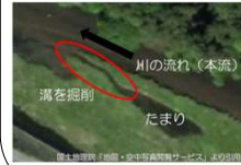
Fig.3 掘削当初の溝
