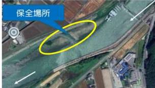
Fig.15 中流に掘られた溝
