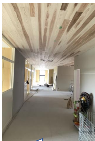
廊下の天井は杉板が貼ってあるとのこと
