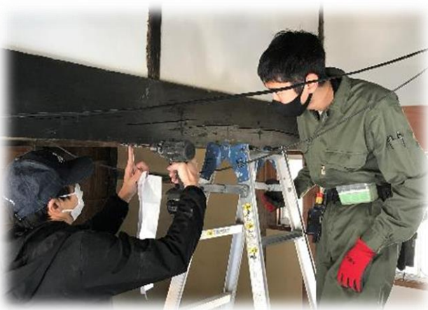
土壁に穴を開ける方法の説明を受けています。 失敗すると、土壁の塗り直しになってしまうので 真剣です。
