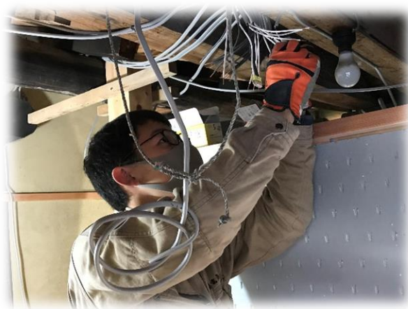
誤結線のないよう、慎重に作業を行います。
