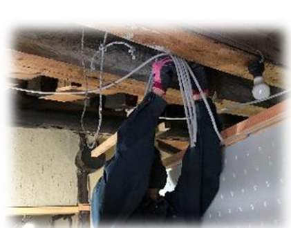
引っ張ってきたケーブルを ステップルで固定しています。
