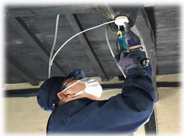
引っ掛けシーリングの取り付け作業。競技会違う体勢のため 作業がしづらく、苦勞しています。
