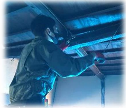
古いケーブルの撤去作業。ステップルがなかなか抜けずに苦勞しています。
