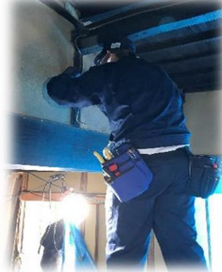
古いケーブルの撤去作業。ステップルがなかなか抜けずに苦勞しています。
