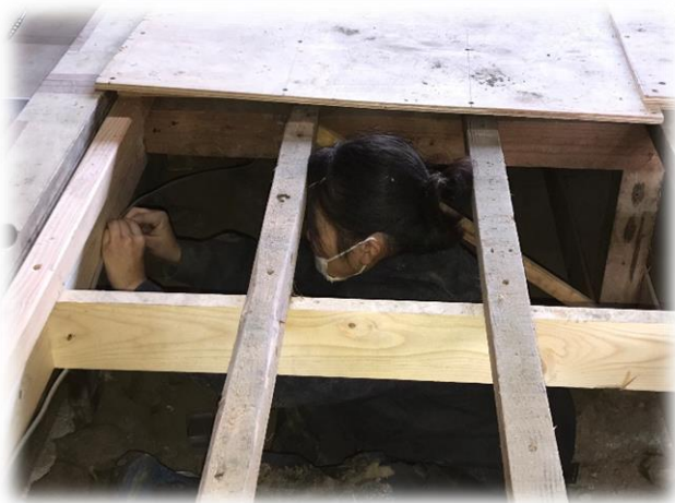
床下配線を行い、ステッplerでケーブルを固定します。生徒は非常に楽しんで作業をしています。
