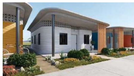
図2 3Dプリンターで作成した16坪の平屋
