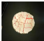
図2:生じたひび割れ
