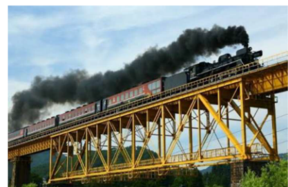
図5 実際にボルチモアトラス構造を用いて建設された一ノ戸川橋梁(福島県)
