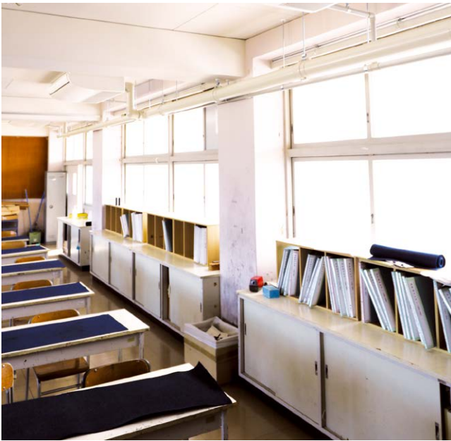
令和7年度（2025）芸術棟の空調設備（書道教室）
