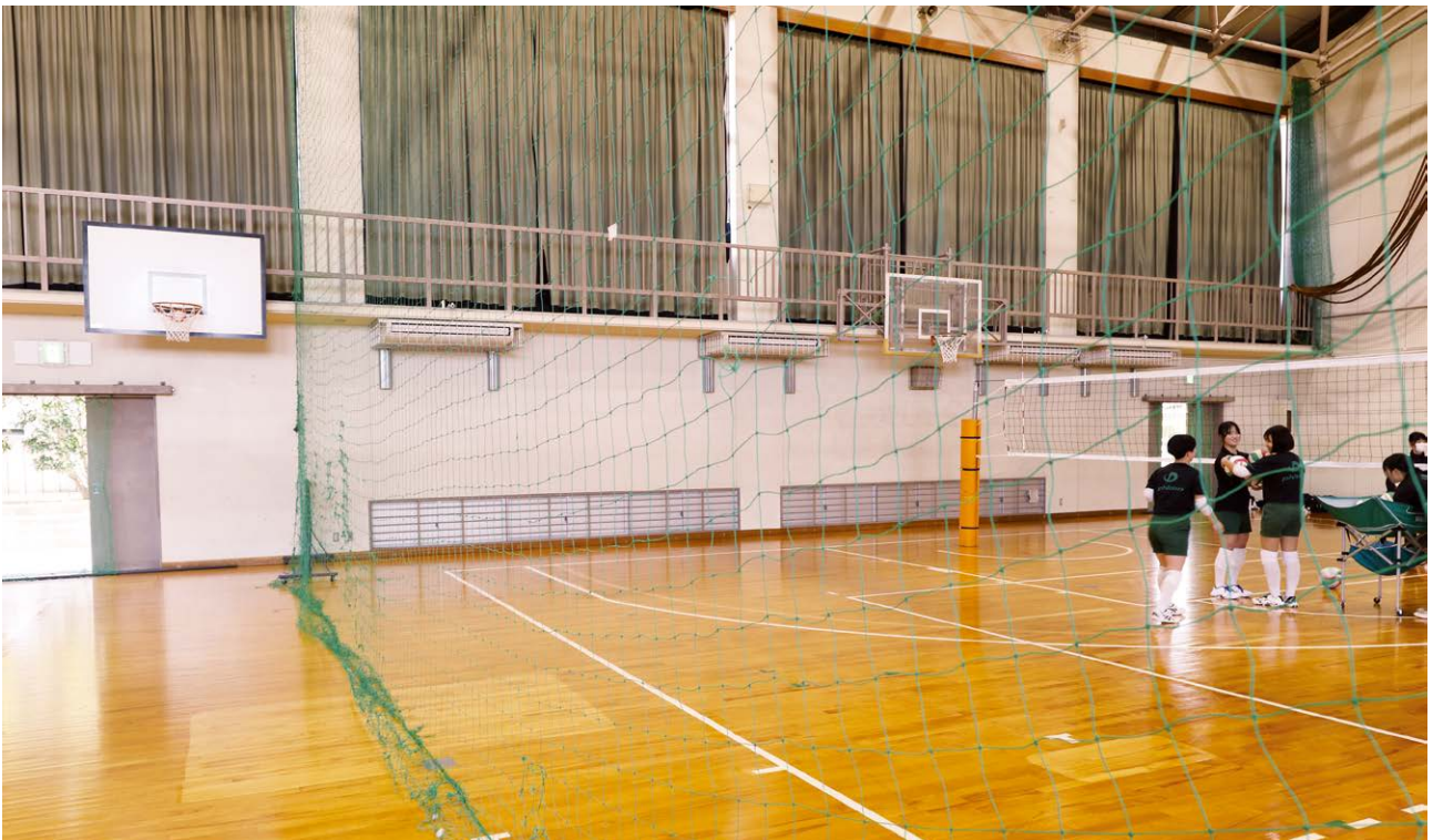
令和5年度（2023）体育館の空調設備が完了
